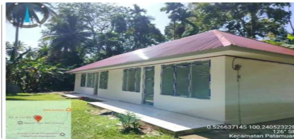
Gambar : Rehabilitasi Pustu Batu Kalang
