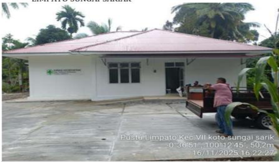
Gambar : Pembangunan Limpato
